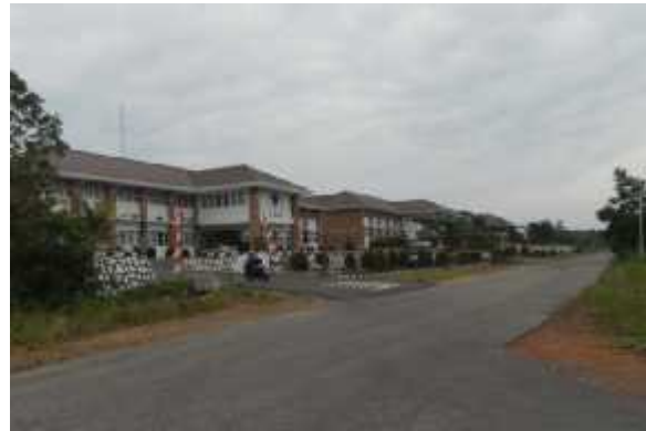
Gambar 1. 4 Fasilitas jalan di lingkungan kampus UBB
